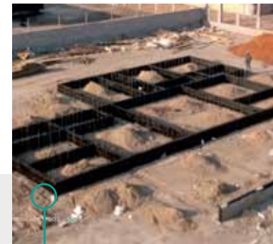
SAPATA ISOLADA COM VIGA BALDRAME
